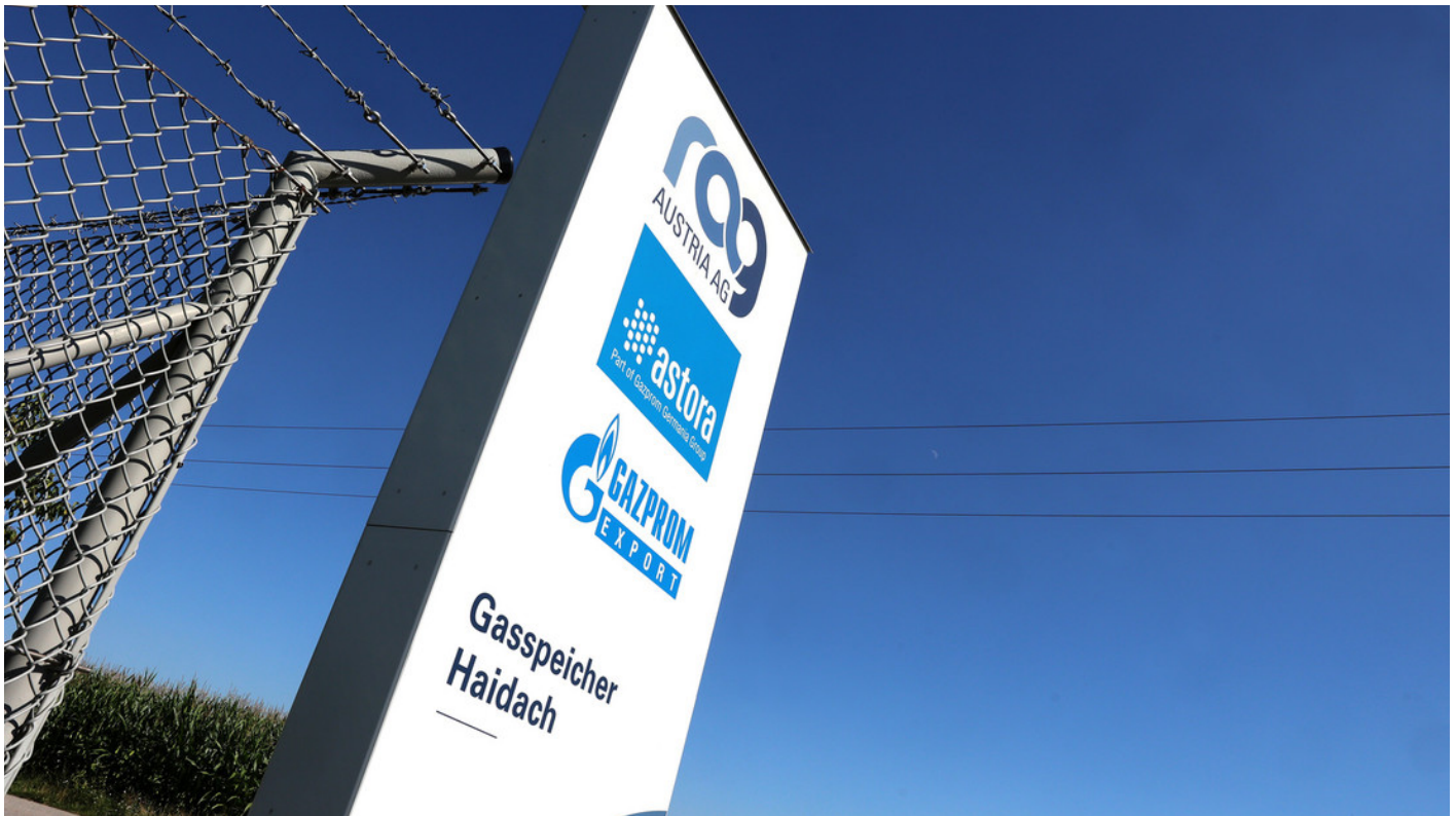
© Alexandra Beier/Getty Images Gasspeicher Haidach in Österreich
